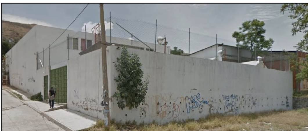
Figura 29 Edificio del CAVVI Oaxaca
